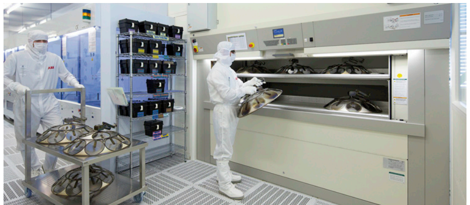
Die Kalottenträger für die Wafer werden im Reinraum Rotomat® CleanStore so lange gelagert, bis sie in der Bedampfanlage zum Einsatz kommen.
