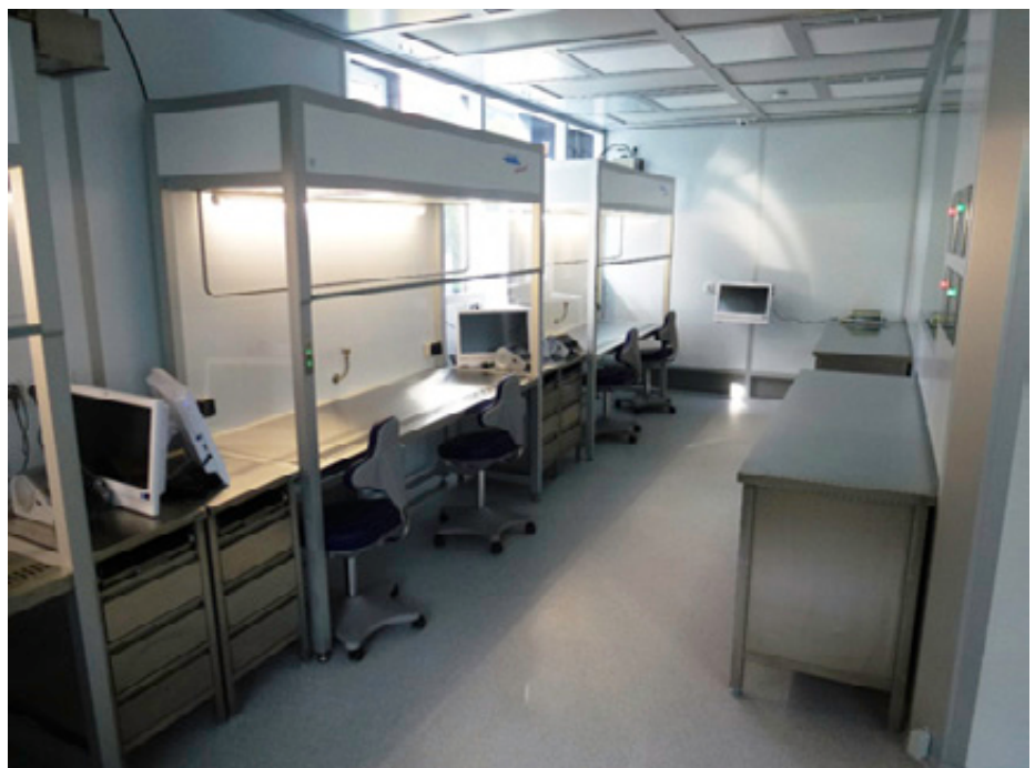
Reinraumlabor für parenterale Ernährung. CleanSteriCell® GMP A in B mit Laminarflow-Arbeitsbänken
