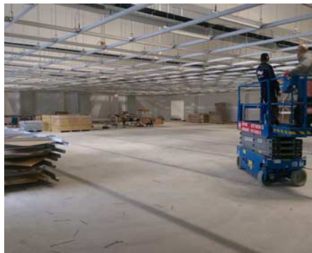
Montage der Reinraumdecke
