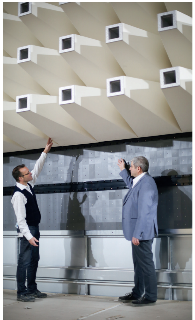
Markus Mettler, Technischer Betriebsleiter von ebm-papst und für den Bau verantwortlich (links) und Martin Schmitt, Abteilungsleiter in der Elektronikentwicklung in der neuen Absorberhalle. (Foto: ebm-papst)
