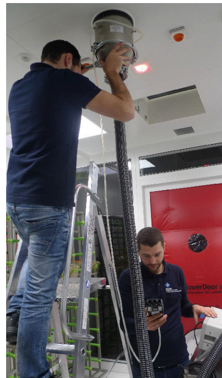
Messung von Einzelkomponenten seitens STZ EURO auf einer Baustelle, nach der Nullmethode.
