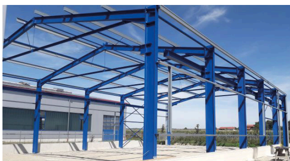
Aufbau der neuen Halle
