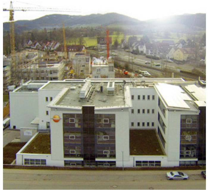
Der Hauptsitz der Testo industrial services GmbH in Kirchzarten.
