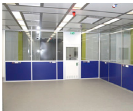
Große Fenster, farbige Wandmodule, integrierte Medienkanäle und LED-Beleuchtung erhöhen die Qualität der Reinraum Arbeitsplätze.
