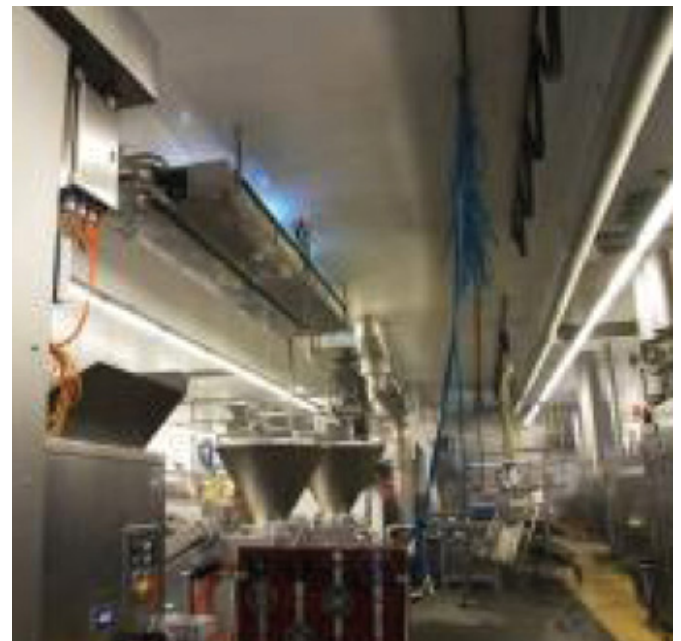
Zum Einsatz kommen UVC-Entkeimungsgeräte aus der E-Serie der sterilAir AG. Das Schweizer Unternehmen arbeitet bereits seit mehr als zehn Jahren erfolgreich mit Micarna zusammen. (Quelle: sterilAir AG)
