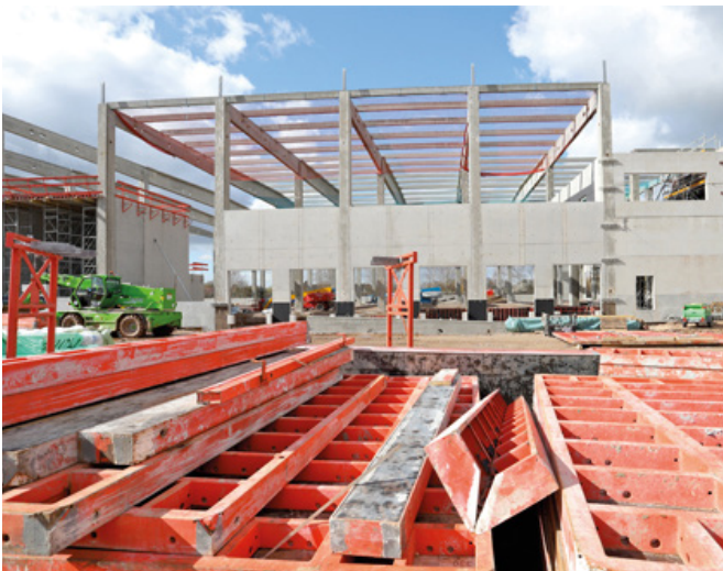
In Bau befindliche Erweiterung des ACTEGA Standortes.
