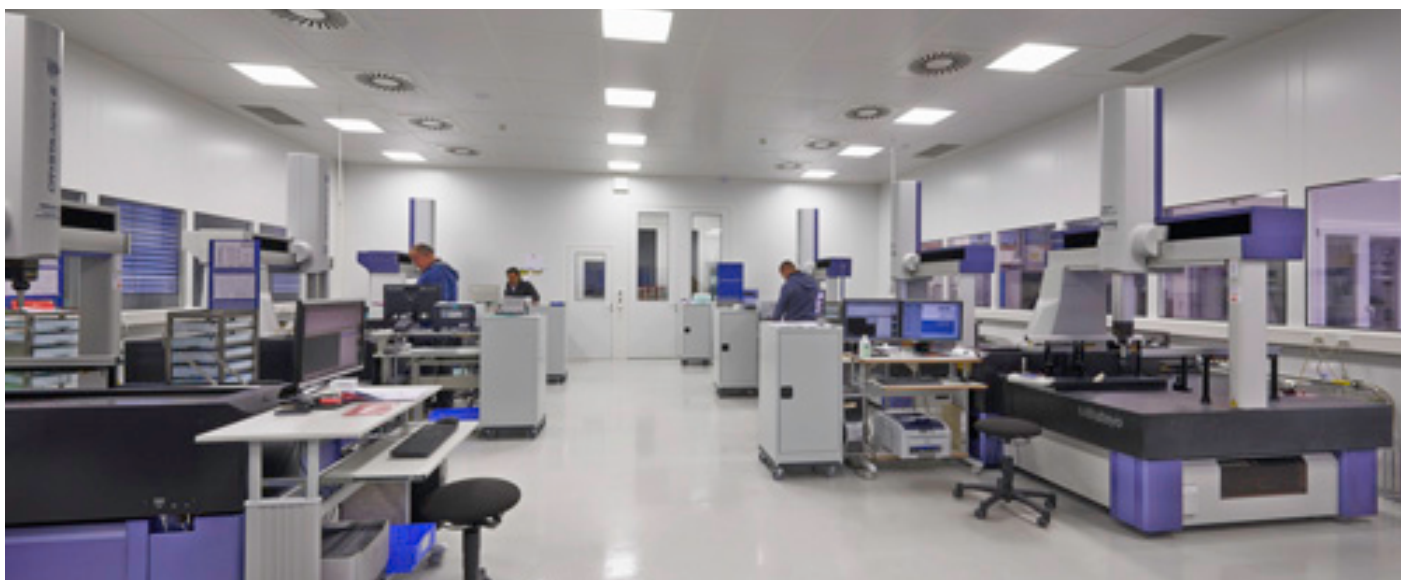
Schlüsselfertiger Messraum von Weiss Klimatechnik – inklusive thermischer Isolierung.
