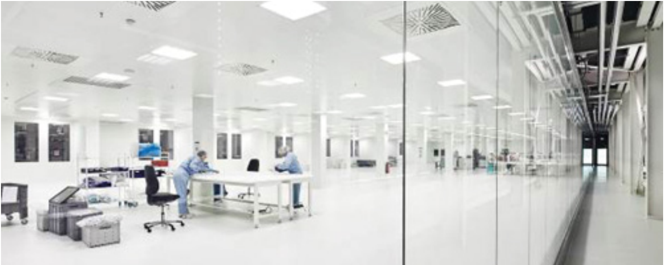
Im Bereich des Besucherflurs verfügt der Reinraum über eine raumhohe, großflächige Glaswand. (Quelle: bc-technology GmbH)
