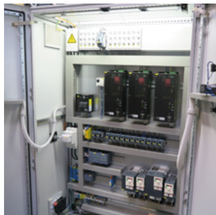
Die Leistung der Ultraschall-Hutschienengeneratoren lässt sich im Bereich von 10 bis 100 Prozent in 1%-Schritten regeln und dadurch optimal an teilespezifische Reinigungsprogramme anpassen. (Bildquelle: Weber Ultrasonics AG)
