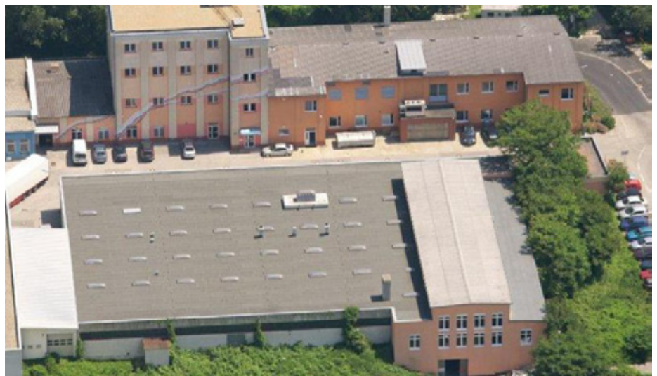
Luftbildaufnahme GOLLER Systems
