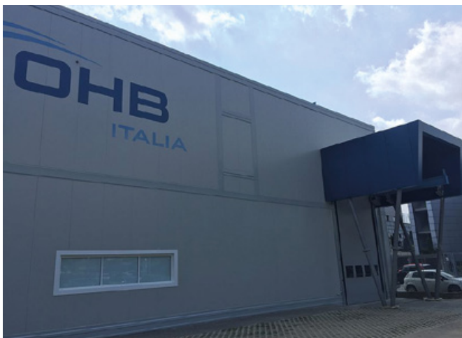
Die Außenansicht der neuen Produktionshalle. (© OHB SE)
