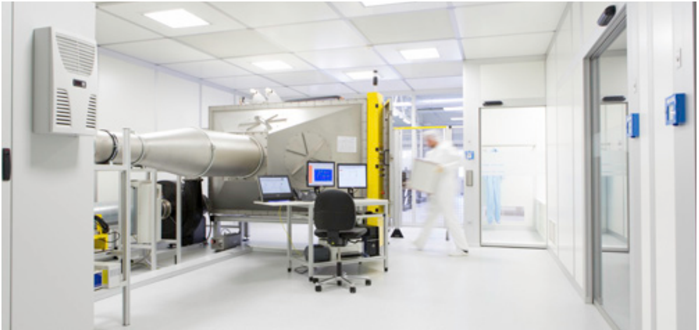
Reinraumzentrum II: Das neue Filterwerk in Steindorf am Ossiacher See
