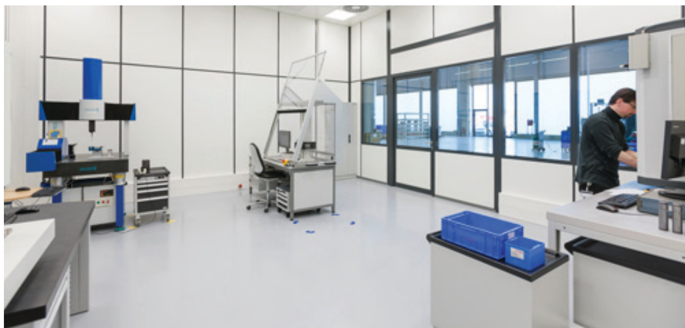
Weiss Klimatechnik plante und lieferte das Projekt schlüsselfertig aus einer Hand – von der Konzeption bis hin zur Abnahmemessung mit kalibriertem Mess-Equipment.
