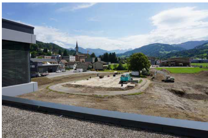
Abb. 1: Baustelle des Erweiterungsbaus der IST AG. Vorbereitung der Parzelle auf den Bau. (Blick vom bestehenden Gebäude an der Stegrütistrasse 14)
