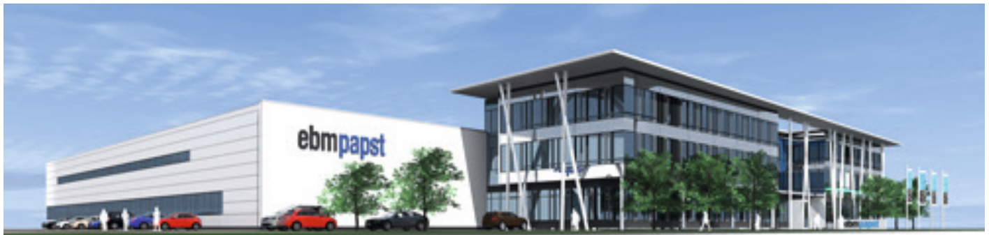
ebm-papst investiert 13 Mio. € in den Neubau seines Standortes in Lauf und stärkt seinen Standort für Getriebe und Antriebstechnik.
